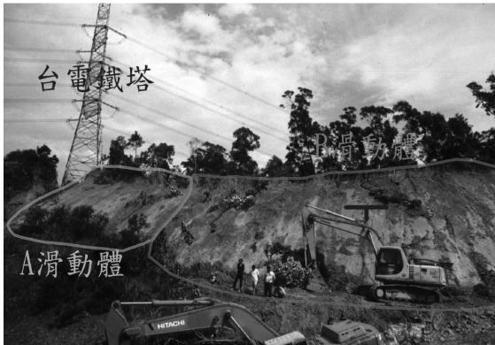
照片 1 林肯大郡滑動體照片，滑動面為頁岩材料，滑動的冠部緊臨台電高壓鐵塔下方（照片位置請見圖 1）
