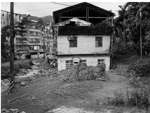
照片 7 新店北宜路土石流照片（1989/06/19），照片右方爲 265 巷 34 號房舍。土石淹埋房舍高度約 1.5 公尺。
