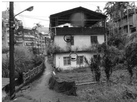
照片 8 新店北宜路 265 巷 34 號房舍現況（2011/10/1）
