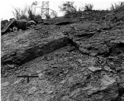
照片 2 滑動區的地質材料主要是薄砂頁互層，風化後即呈鬆軟軟弱剝離狀態（照片位置請見圖 1）
