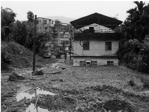
照片 5 新店北宜路土石流照片，照片右方爲 265 巷 34 號房舍。土石淹埋房舍高度約 2 公尺（1988/10/28）。
