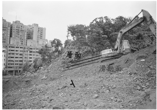
照片 4 健康博市滑動體照片，由崩滑體東北側往西拍攝順向坡滑入基地之照片，照片左側的集合式住宅是基澳坑路西南側。滑動體之地質材料主要是石底層的砂頁互層。(照片位置參見圖 11)
